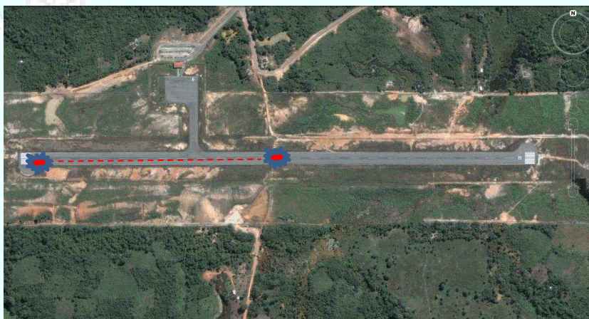
Figura 1- Croqui da ocorrência, com evidencia do ponto de toque e parada total da aeronave.
