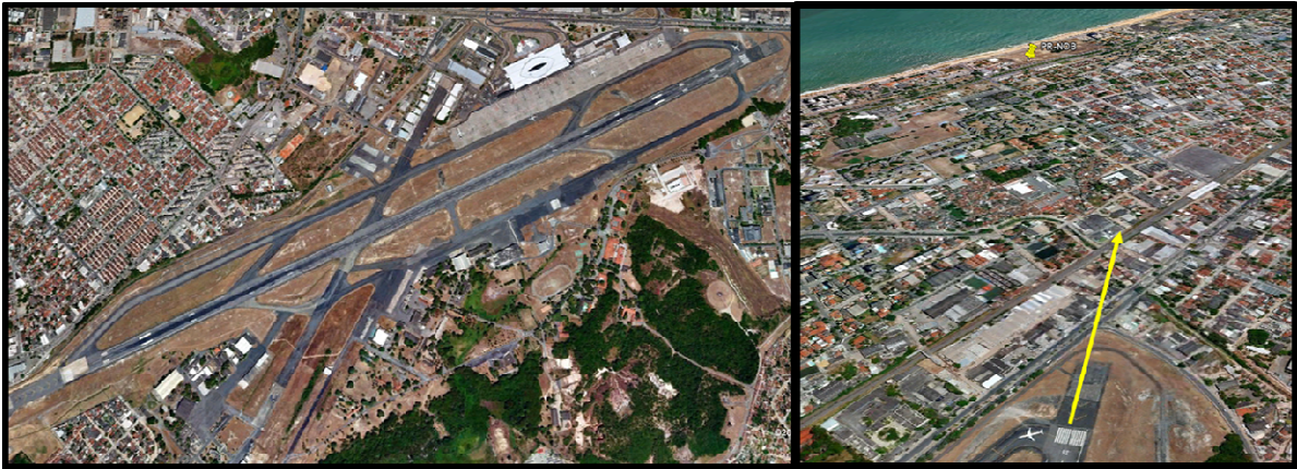
Figura 7 - Vista aérea da reta de decolagem da pista 18.
