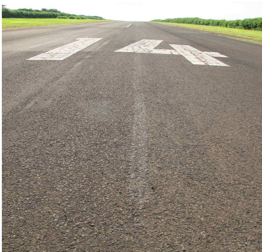
Figura 3 – Marcas da roda direita na pista de pouso.
