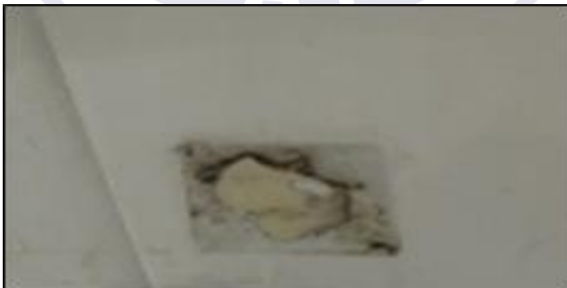
Figura 2 - Visão do local de instalação da plaqueta de identificação.
