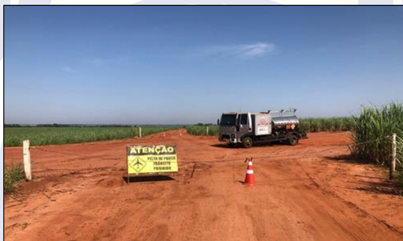
Figura 4 - Bloqueio e sinalização em um dos lados do cruzamento.
