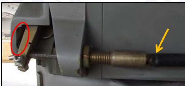
Figura 5 - O círculo vermelho evidencia a folga de aproximadamente 4 mm entre a alavanca e a unidade de alojamento. A seta amarela mostra o condúite do cabo (PN 704A31-813009) de acionamento mecânico esgaçado.
