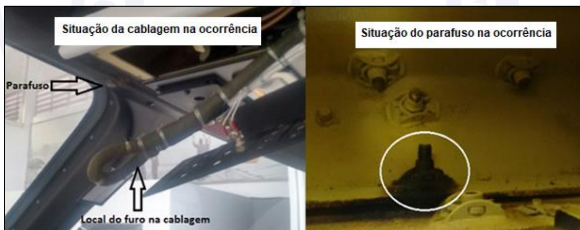
Figura 1 - Situação da cablagem e do parafuso na ocorrência.
