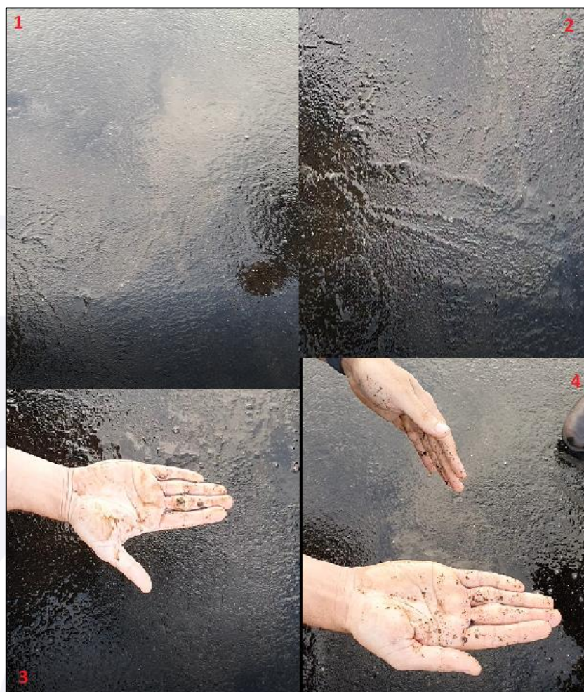
Figura 5 - Contaminação da superfície de pouso da pista de SWON.
