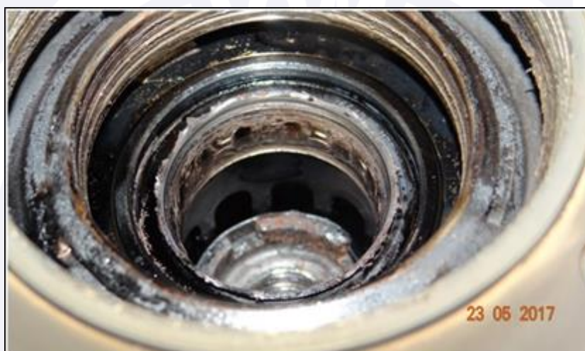
Figura 9 - Vista geral do rolamento G3 danificado.
