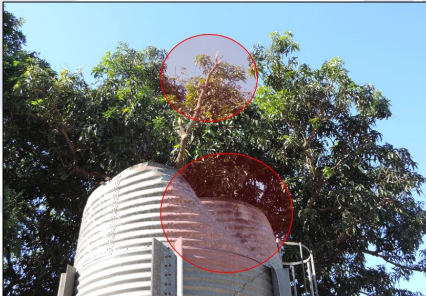
Figura 5 - Local de impacto contra a árvore e a caixa d'água.
