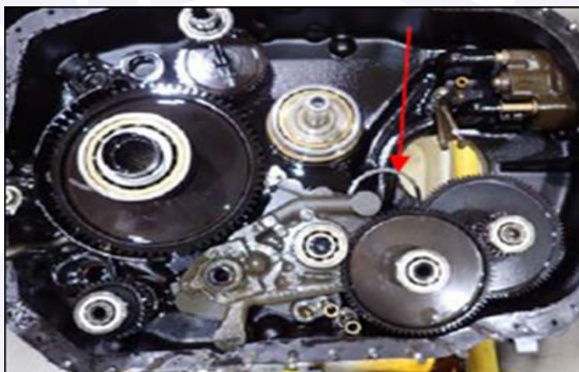
Figura 11 - Anel de retenção do rolamento nº 2 encontrado dentro da caixa de engrenagens.
