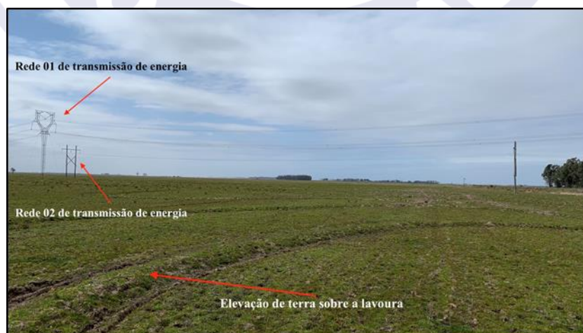
Figura 3 - Linhas de transmissão de energia e elevações do terreno.
