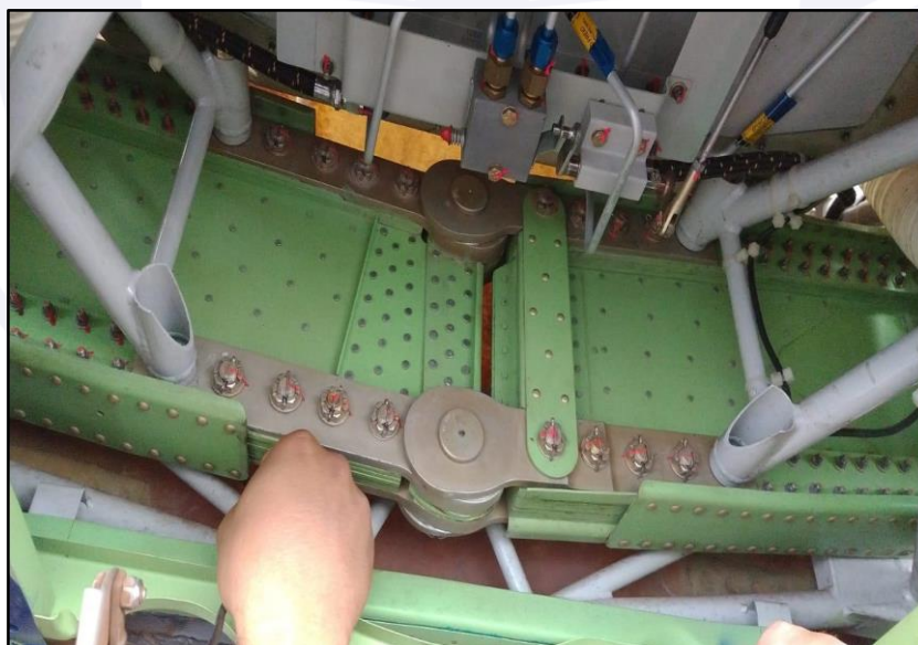
Figura 2 - Registro fotográfico da estrutura de fixação das semiasas à estrutura da fuselagem, vista a partir do acesso inferior.
