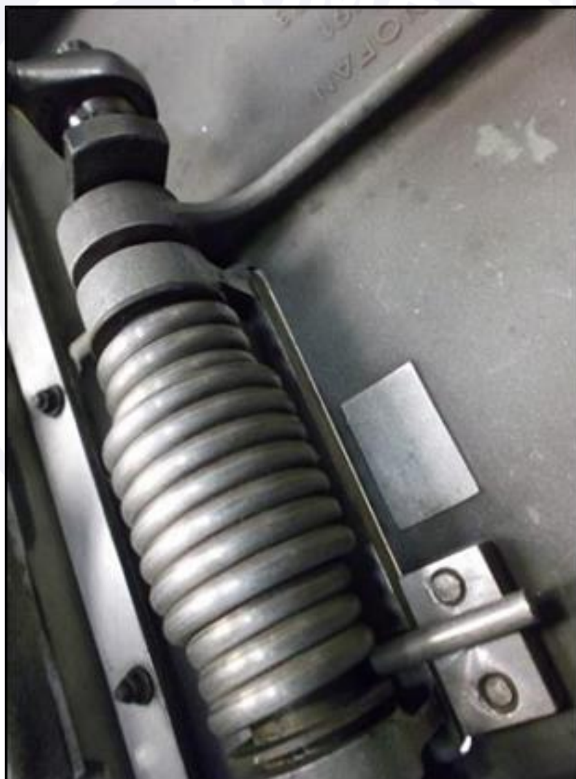
Figura 5 - Vista interna do small flap completamente fechado, após acionamento manual.
