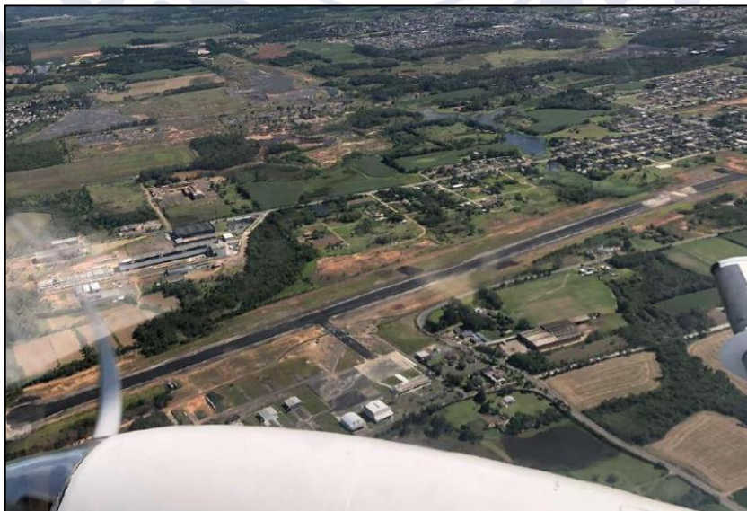
Figura 4 - Vista aérea da pista de SSIM sem as marcações horizontais de interdição.
