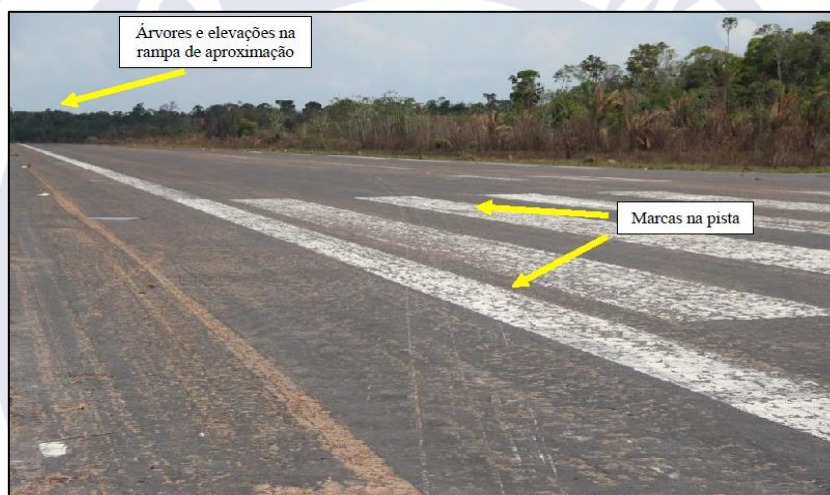
Figura 3 - Marcas da aeronave na pista e obstáculos no setor de aproximação.
