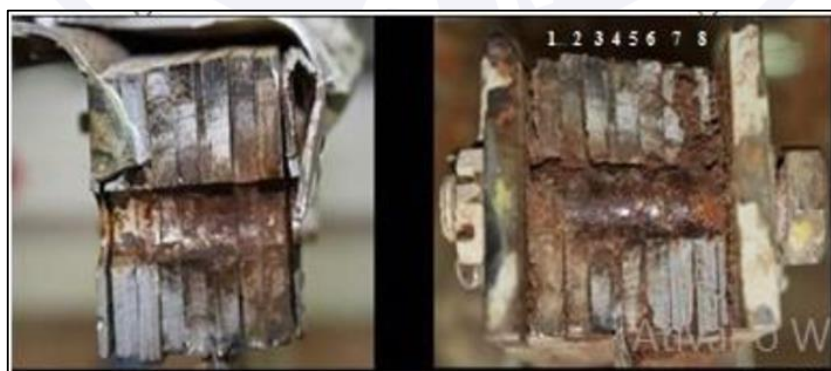
Figura 13 - Vista da fratura iniciada na chapa 1 e corrosão no pino.
