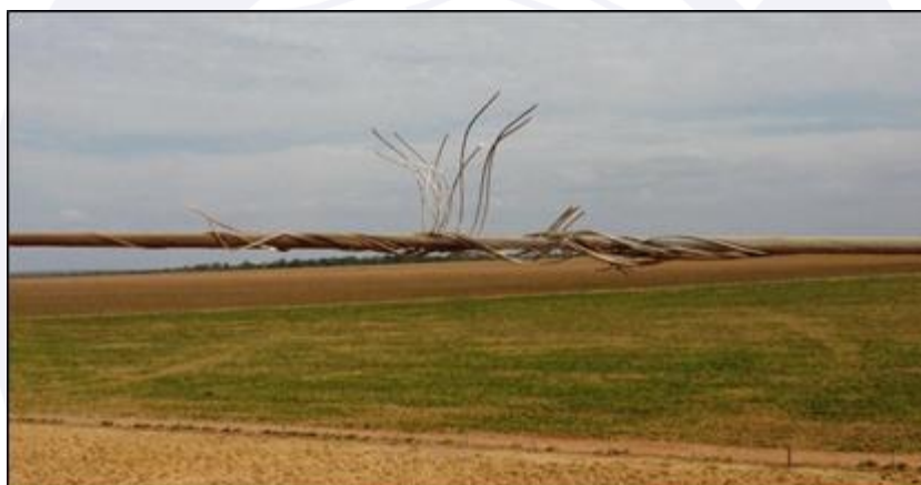
Figura 3 - Vista do cabo de transmissão após a colisão.
