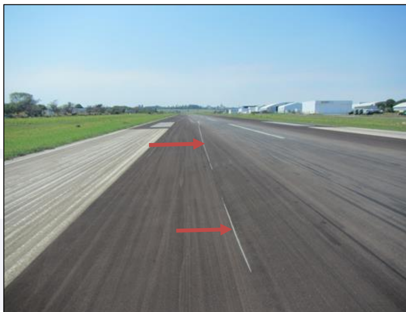
Figura 5 - Marcas deixadas pelo contato do estabilizador vertical/leme com a pista. Após esse primeiro contato, houve a colisão da hélice contra o terreno.
