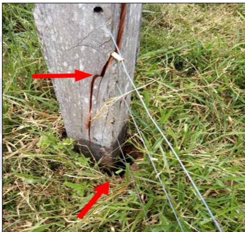
Figura 1 - Imagem aproximada do mourão, após o impacto com a perna do trem de pouso. Na imagem, identificados pela seta vermelha, é possível observar a rachadura e o deslocamento lateral dele por meio da abertura no solo.
