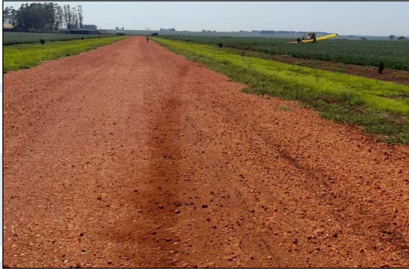
Figura 2 - Detalhe das marcas deixadas na pista pela aeronave.
