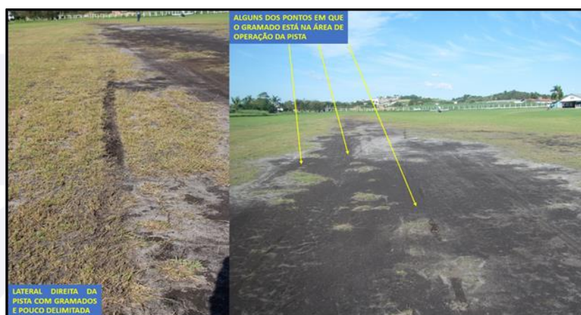
Figura 3 - Marcas da trajetória da aeronave e ondulações na pista.
