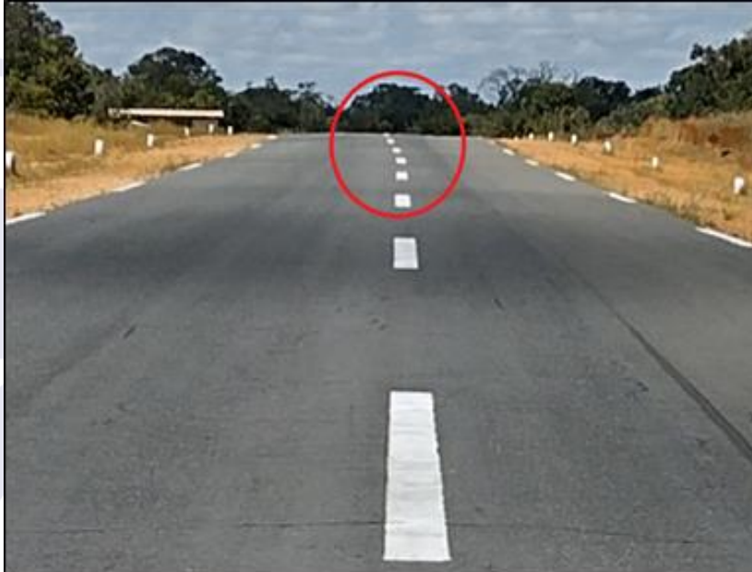
Figura 3 - Imagem da pista. No detalhe destacado pelo círculo vermelho, o desvio da faixa central para a esquerda.
