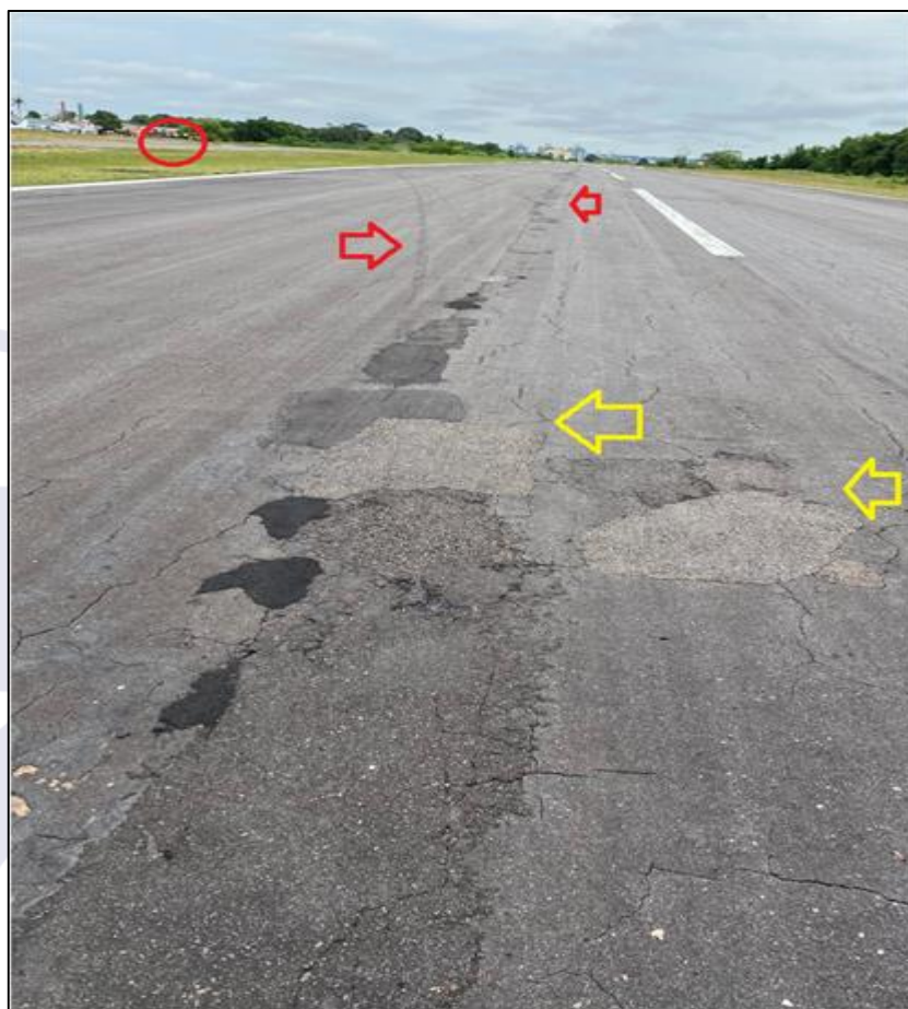
Figura 2 - Remendos da pista (setas amarelas), marcas do pneu da aeronave (setas vermelhas) e local de parada da aeronave (círculo vermelho).
