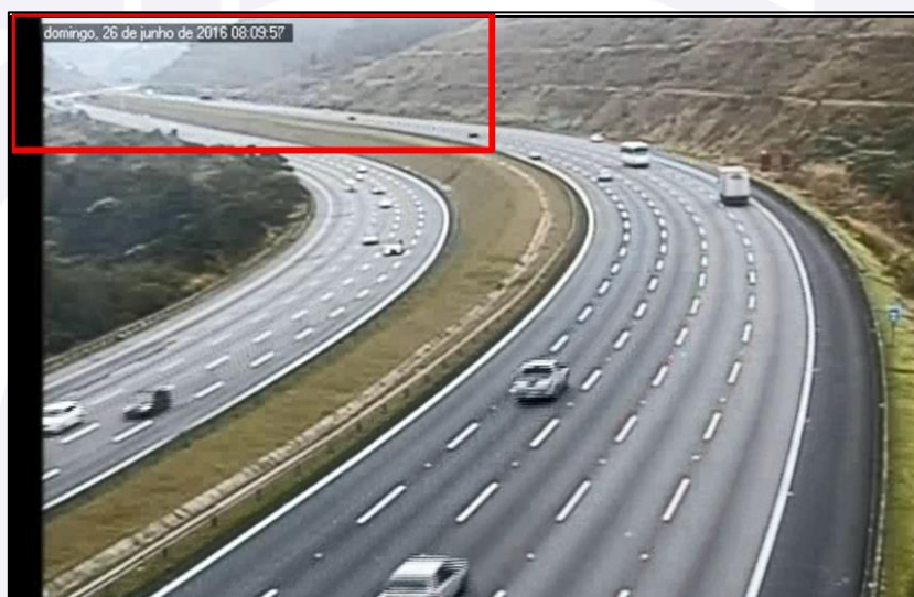
Figura 10 - Degradação da meteorologia evidenciada na Rodovia Bandeirantes - KM 045.
