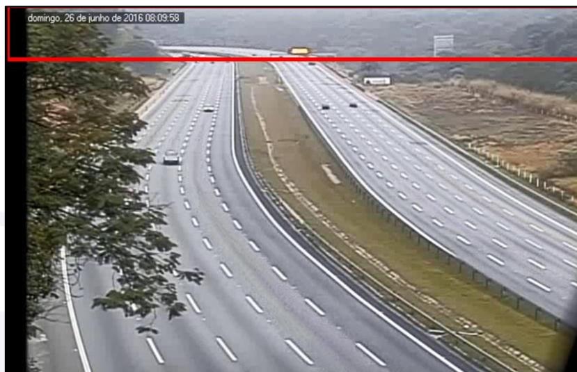
Figura 9 - Degradação da meteorologia evidenciada na Rodovia Bandeirantes - KM 043.
