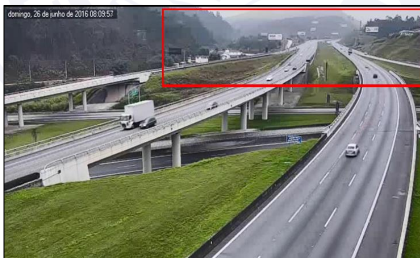
Figura 11 - Degradação da meteorologia evidenciada na Rodovia Bandeirantes - KM 047.
