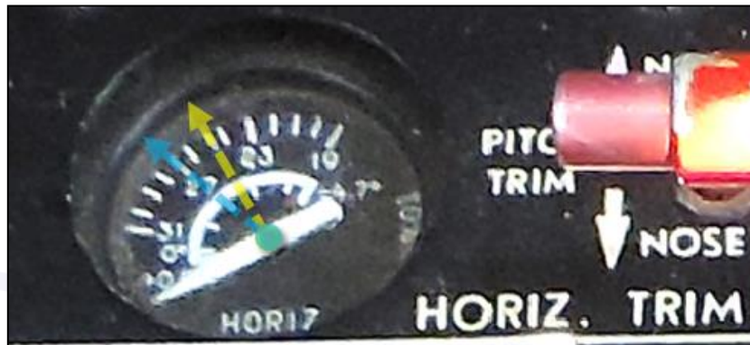
Figura 17 - Mostrador de “trimagem” do estabilizador horizontal.
