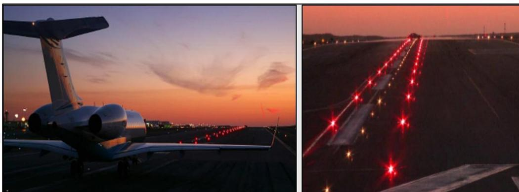
Figura 25 - As luzes vermelhas do RWSL do Aeródromo de Los Angeles indicam para a aeronave que houve uma incursão em pista.
