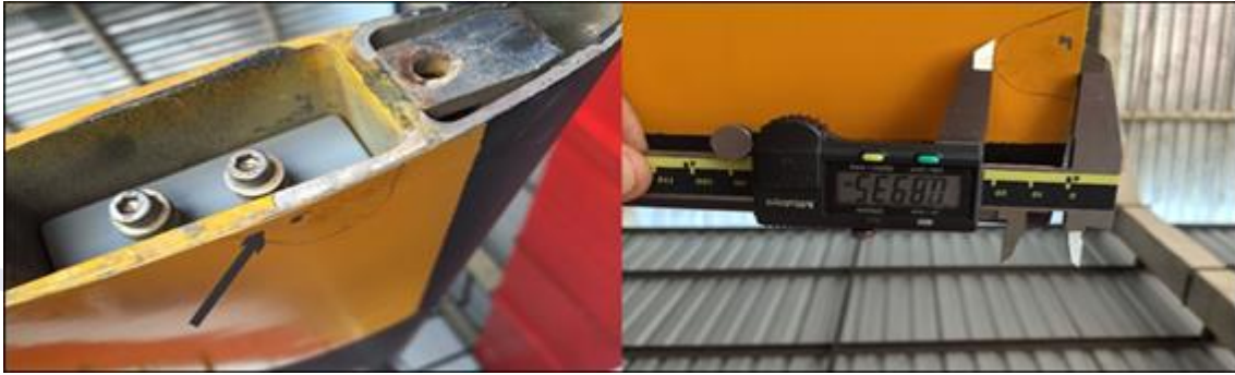
Figura 2 - Descolamento (separação) da camada externa ( skin ) da pá do rotor principal, SN 6842.
