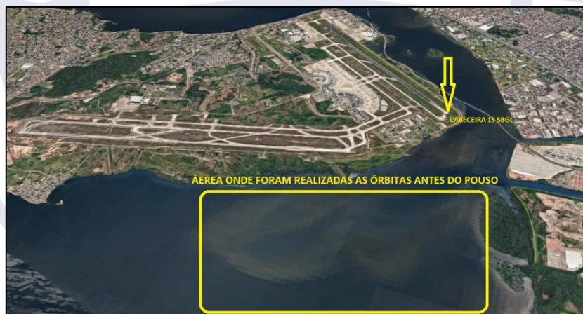
Figura 2 - Local sobrevoado pela aeronave.
