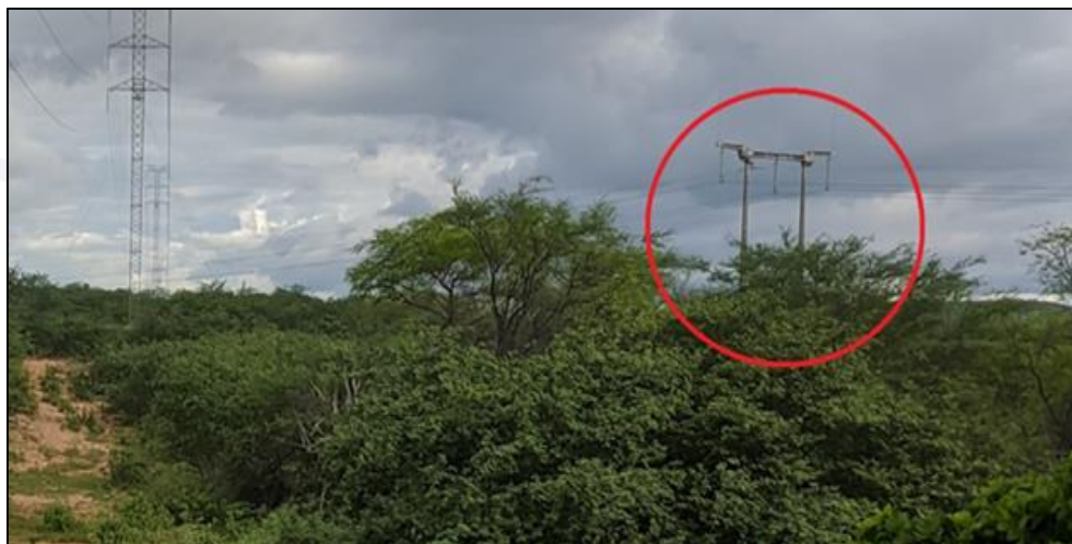
Figura 32 - Proximidades do cruzamento entre a LT 138 kV e a LT 230 kV, com destaque para a ausência de sinalização da torre (suporte) da LT 138 kV.
