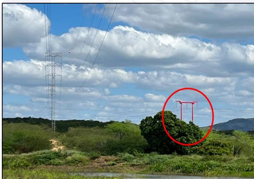
Figura 39 - Sinalização por pintura dos suportes (torres) da LT 138 kV, após o acidente.
