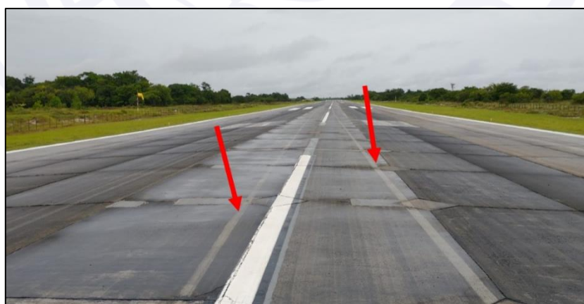
Figura 17 - Marcas brancas dos pneus da aeronave na pista.
