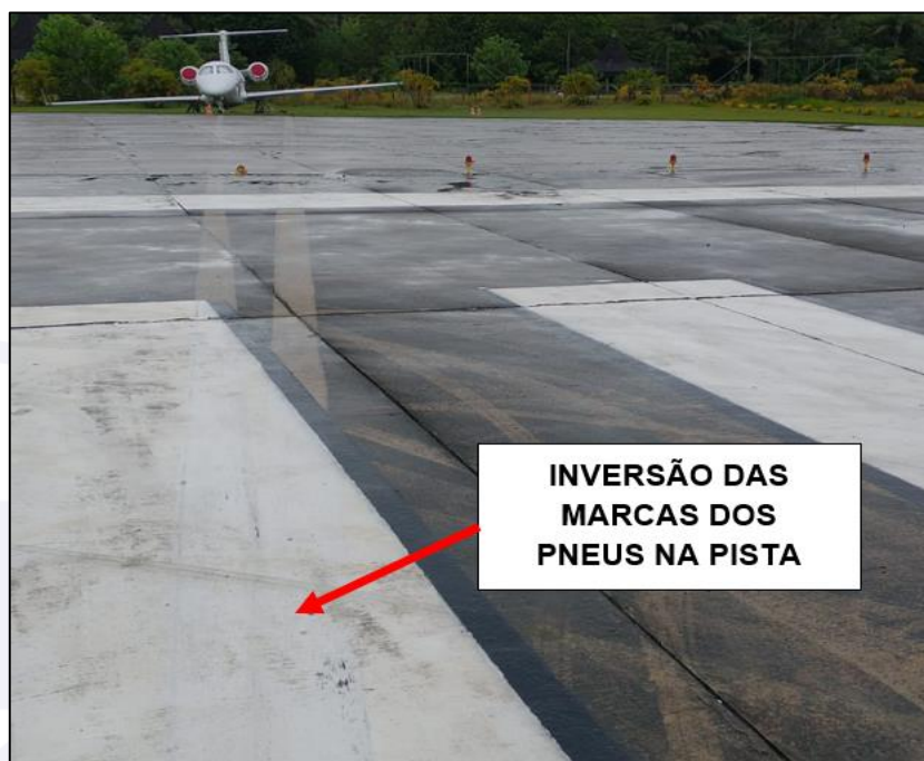
Figura 18 - Marcas dos pneus indicando o giro de 180° da aeronave.
