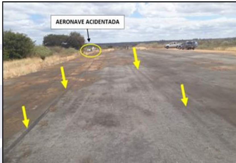
Figura 5 - Marcas de pneus deixadas na pista.
