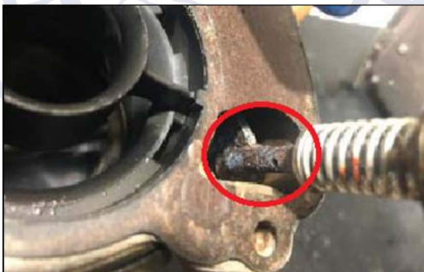
Figura 3 - Corrosão galvânica severa na sua haste do Conjunto do Êmbolo da Bomba ( Pump Plunger Assembly ).
