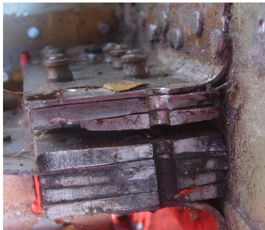
Figura 26: PT-GHP. Seção transversal da fratura através do furo de 3/16 pol, mesa inferior, apresentando marcas de praia típicas de fadiga.
