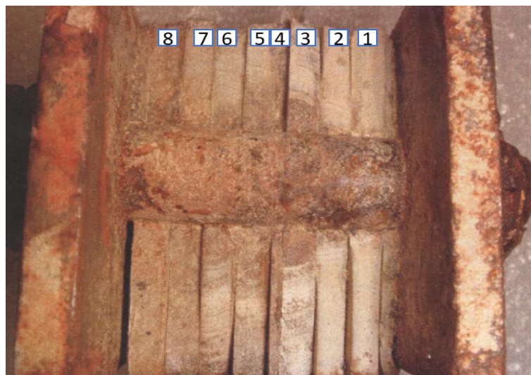
Figura 42: PT-GUR. Detalhe da fratura por fadiga. Trincas iniciadas nas paredes de contato do furo com o pino e a propagação ocorreu da chapa 8 em direção à chapa 1.
