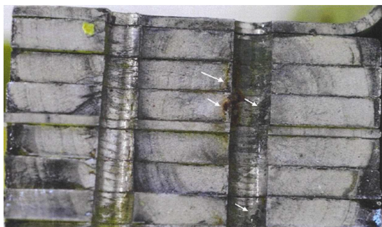
Figura 56: PT-UII. Setas brancas indicando pontos de corrosão e ranhuras internas evidenciadas após a remoção dos pinos de 3/16 pol.
