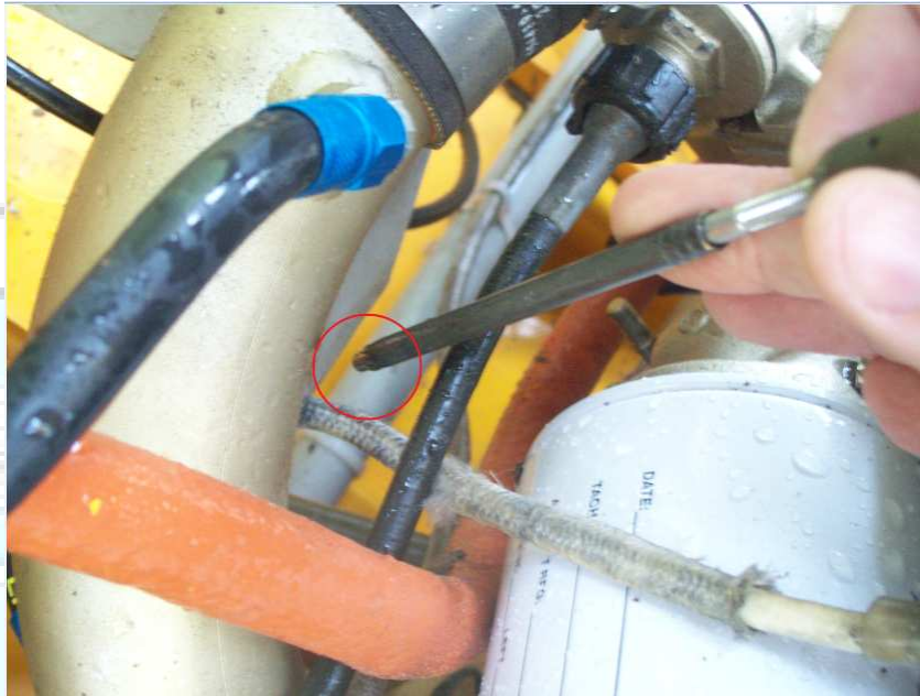
Figura 3 - Vista do cabo da haste do manete de potência rompido. |
