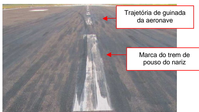
Figura nº5 Marcas do trem de nariz na pista
