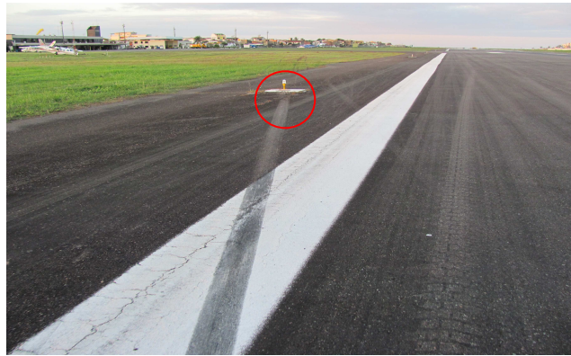
Figura nº7 Marcas deixadas na pista pelo trem de pouso do nariz
