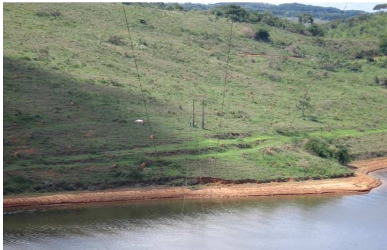
Figura 03 - Vista aérea da rede elétrica.
