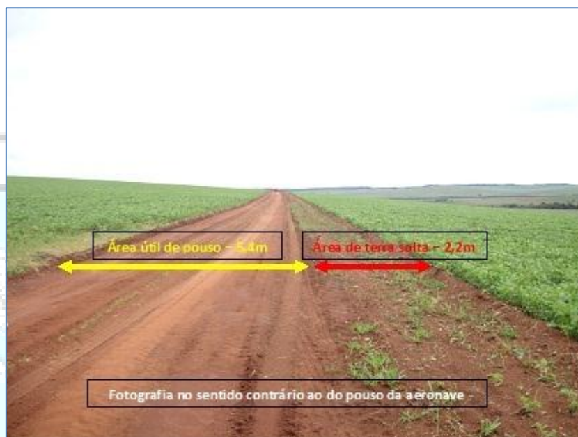
Figura 2 – Vista da área de pouso eventual (sentido contrário ao do pouso).
