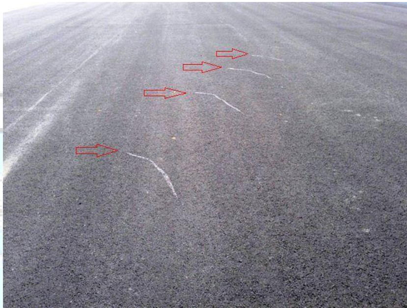
Figura 2 - Marcas na pista causadas pelo toque das pás da hélice
