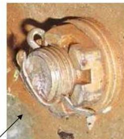
Figura 23 - Parafusos com corrosão e sinais de concentração de esforços devido a desalinhamento das chapas e baixo torque na união das mesmas.
