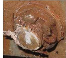
Figura 22 - Parafusos com corrosão e sinais de concentração de esforços devido ao desalinhamento das chapas e porca do 5º furo apresentando corrosão.
