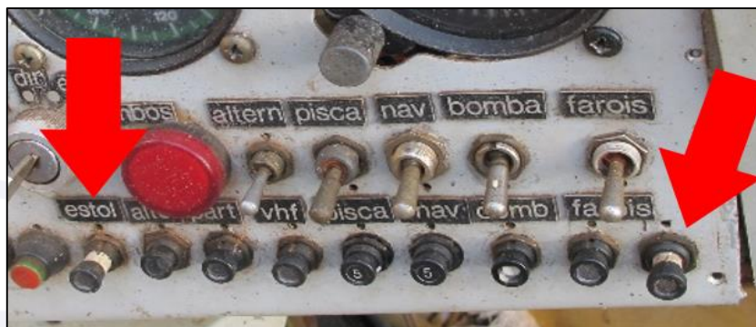
Figura 10 - Painel de disjuntores.
