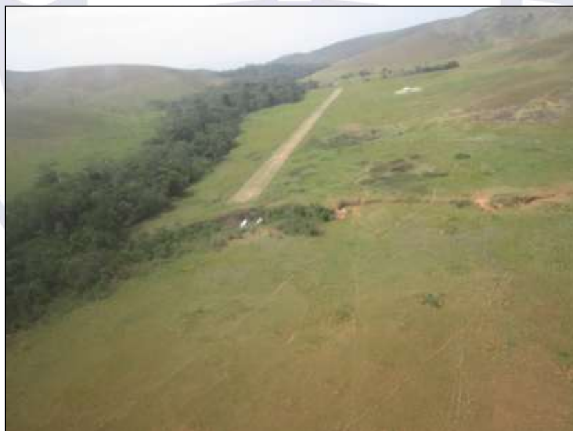
Figura 1 – Visão aérea da pista.
