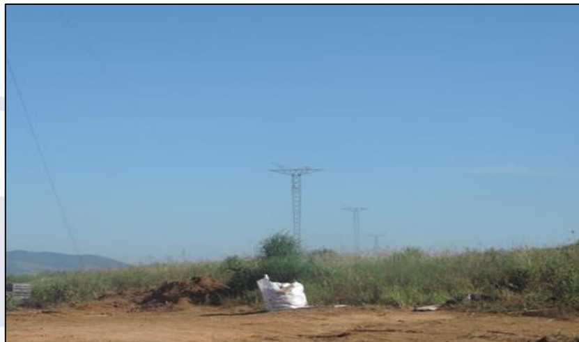
Figura 2 - Torres de sustentação.
