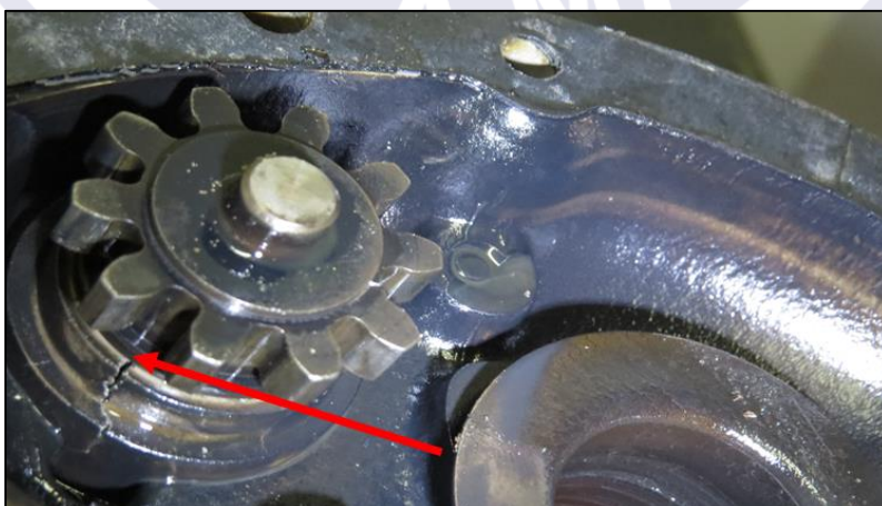
Figura 3 - Trinca no adaptador da bomba de vácuo.
