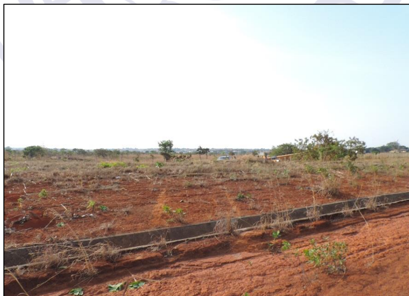
Figura 3 - Dreno paralelo à pista, há aproximadamente 25 metros de distância dessa.
