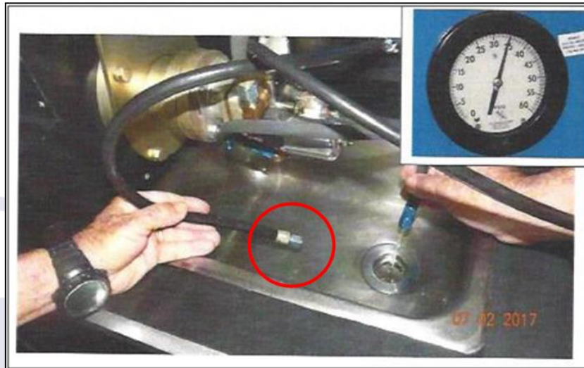
Figura 5 - Teste inicial da bomba de combustível evidenciando baixa pressão e falta de retorno de combustível.
