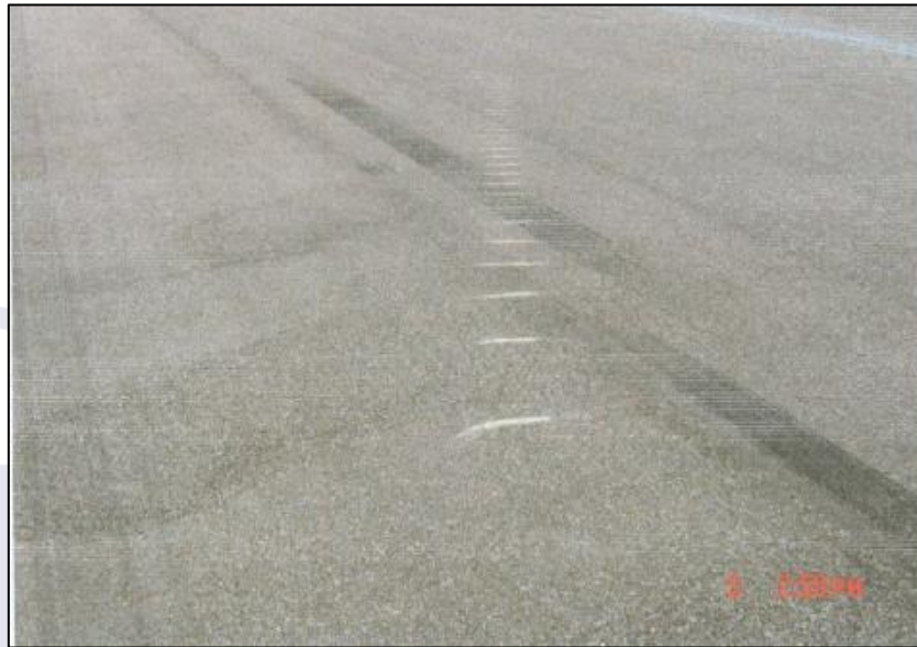
Figura 2 - Marcas deixadas na pista pelas pás da hélice.
