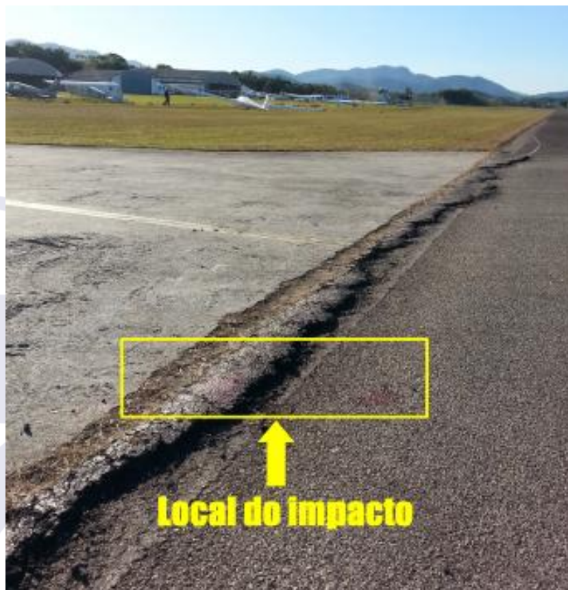
Figura 2 - Local do impacto da asa esquerda da aeronave PT-PJE com a pessoa na margem da pista.
