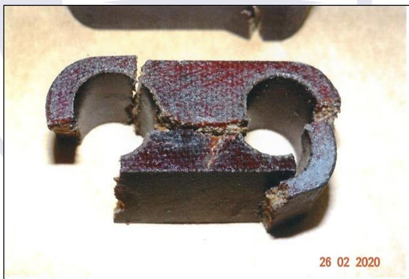
Figura 4 - Vista aproximada do link da pá com apresentação de dobra.
