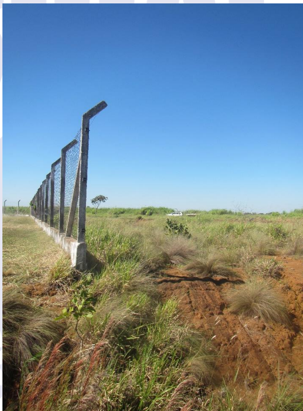
Figura 3 - Local onde a cerca operacional sofria interrupção (descontinuidade).
